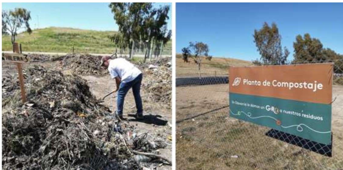
Figura 18 Planta de compostaje de Olavarría 10
